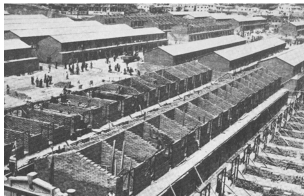
圖 23：施工中的包寧平房，摘自徙置處 1954-55 年年 報。
