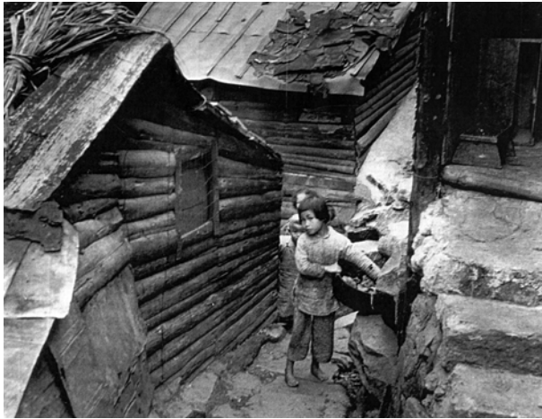
圖 3：石硤尾木屋區常見的小道窄巷，各間木屋緊緊相連，大火一起，將蔓延整個木屋區（HKRS163/1/1578）。
