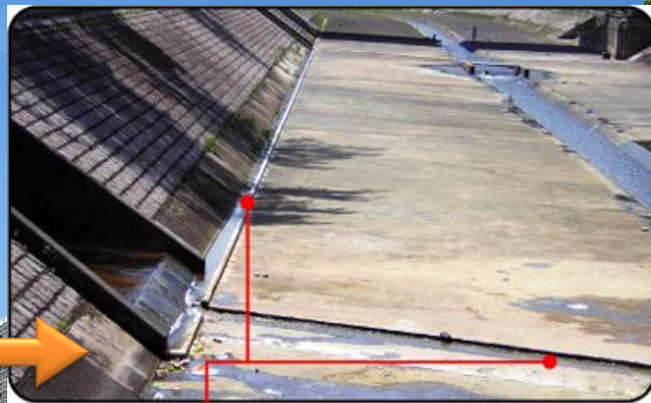
加設旱流排水渠及渠邊石壩
